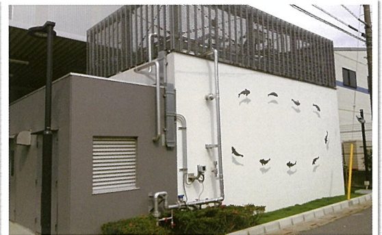
担体処理システム 除害施設外観
